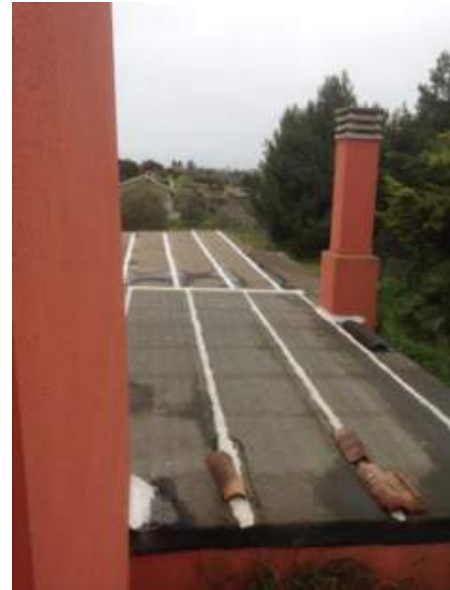
Foto Numero 6 - Copertura Patio
