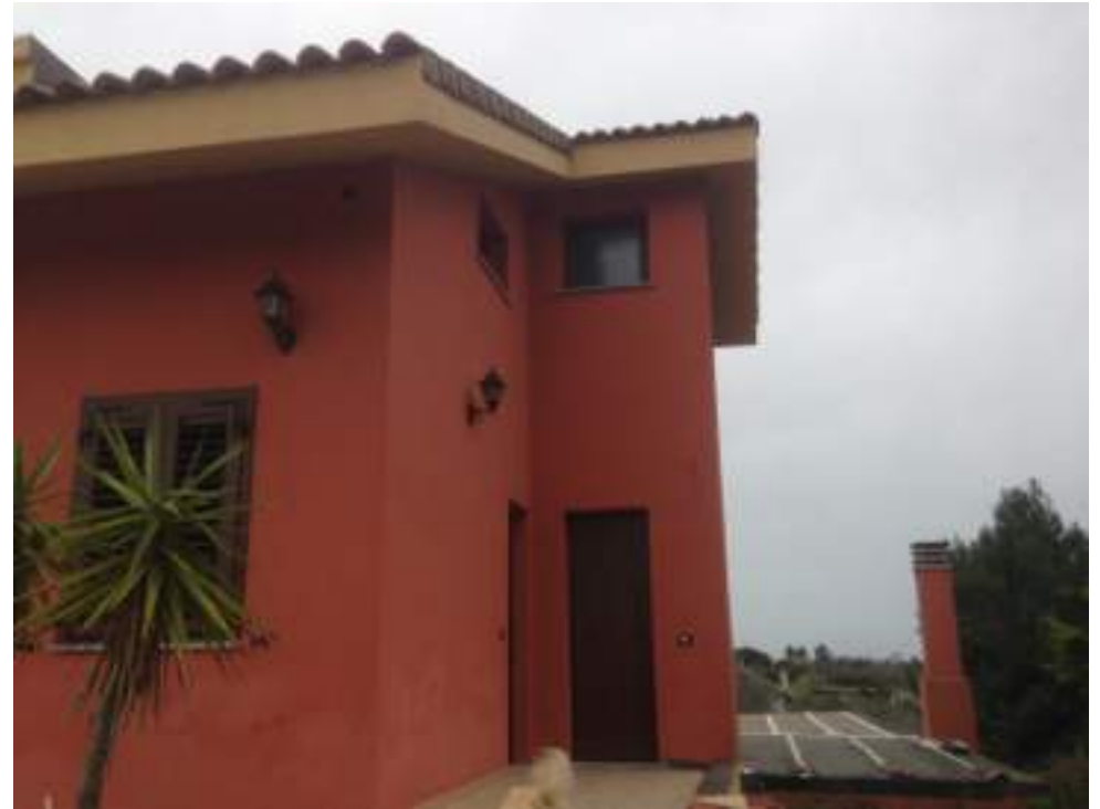
Foto Numero 12 - Ingresso Piano Terra e Soffitta Abitabile
